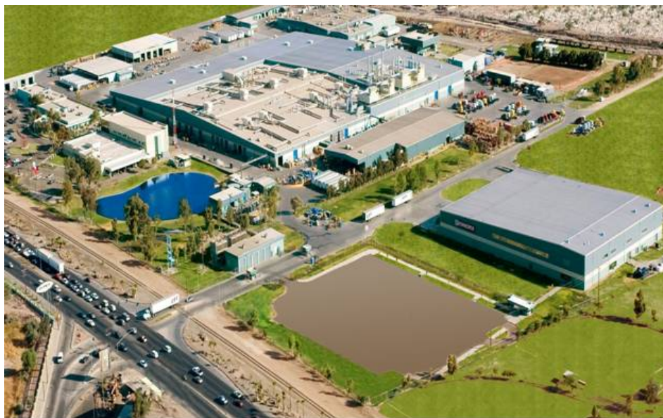
Instalações da Kenworth em Mexicali, Mexico
